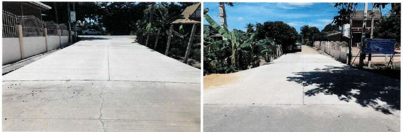
โครงการก่อสร้างทางเชื่อมถนนแจ้งเจริญสุข
