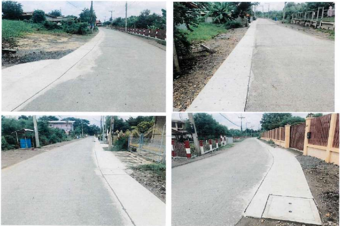
โครงการก่อสร้างท่อระบายน้ำถนนสายคลองข่อยถึงวัดเกตุ
